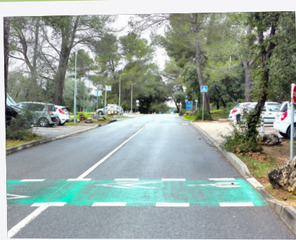
Amélioration de la voirie, sécurisation et stationnements supplémentaires à la Zone de l'Argile
