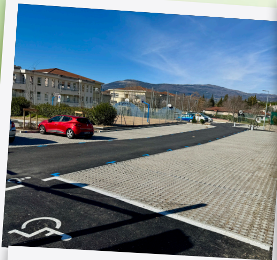
Doublement de la capacité du parking de Grand Jardin
