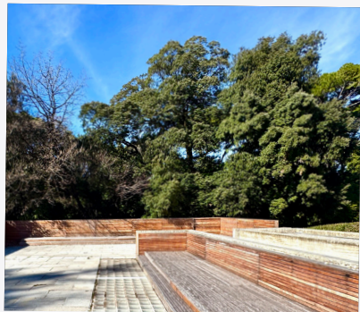
Rénovation de la terrasse des ateliers pédagogiques dans le parc du château
