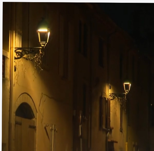
Rénovation de l'éclairage public pour réduire la facture énergétique et préserver la biodiversité
