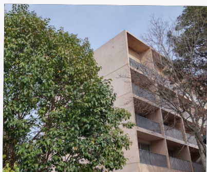
Des logements en coeur de ville pour faciliter l'accessibilité aux services, activités et commerces
