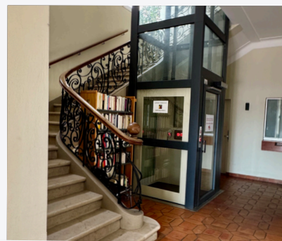
Un ascenseur pour rendre le 1er étage de la Mairie accessible aux personnes à mobilité réduite
