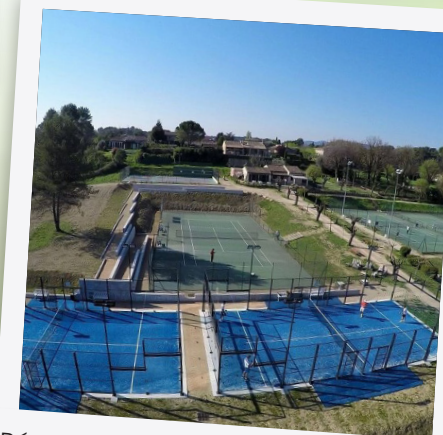
Rénovation du club-house du tennis et création de 2 courts de padel
