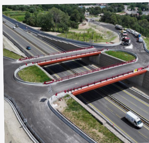
L'ouverture de l'échangeur de la Paoute a permis de diminuer de plus de 20% le trafic sur le boulevard urbain.
